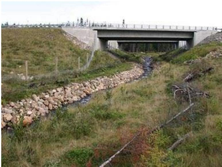
Figure 28. Exemple de passage pour la grande faune sous la route 175.
